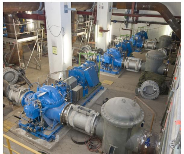
**Bild 7:** Filter Typ W-SS DN800/PN10 im Neubau des Steinkohleblocks 9 der Großkraftwerk Mannheim AG (GKM)
